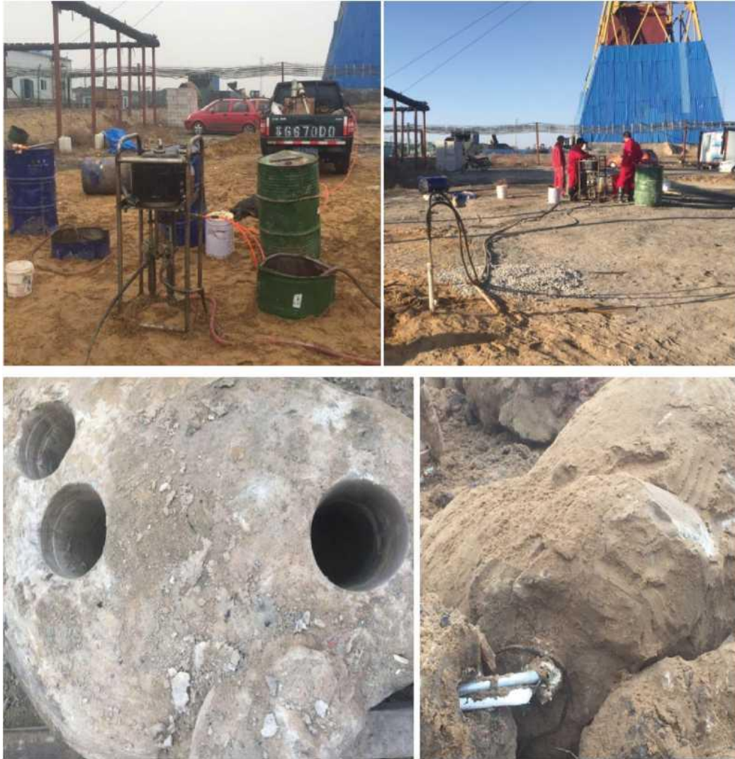
图 10-1 施工现场情况
