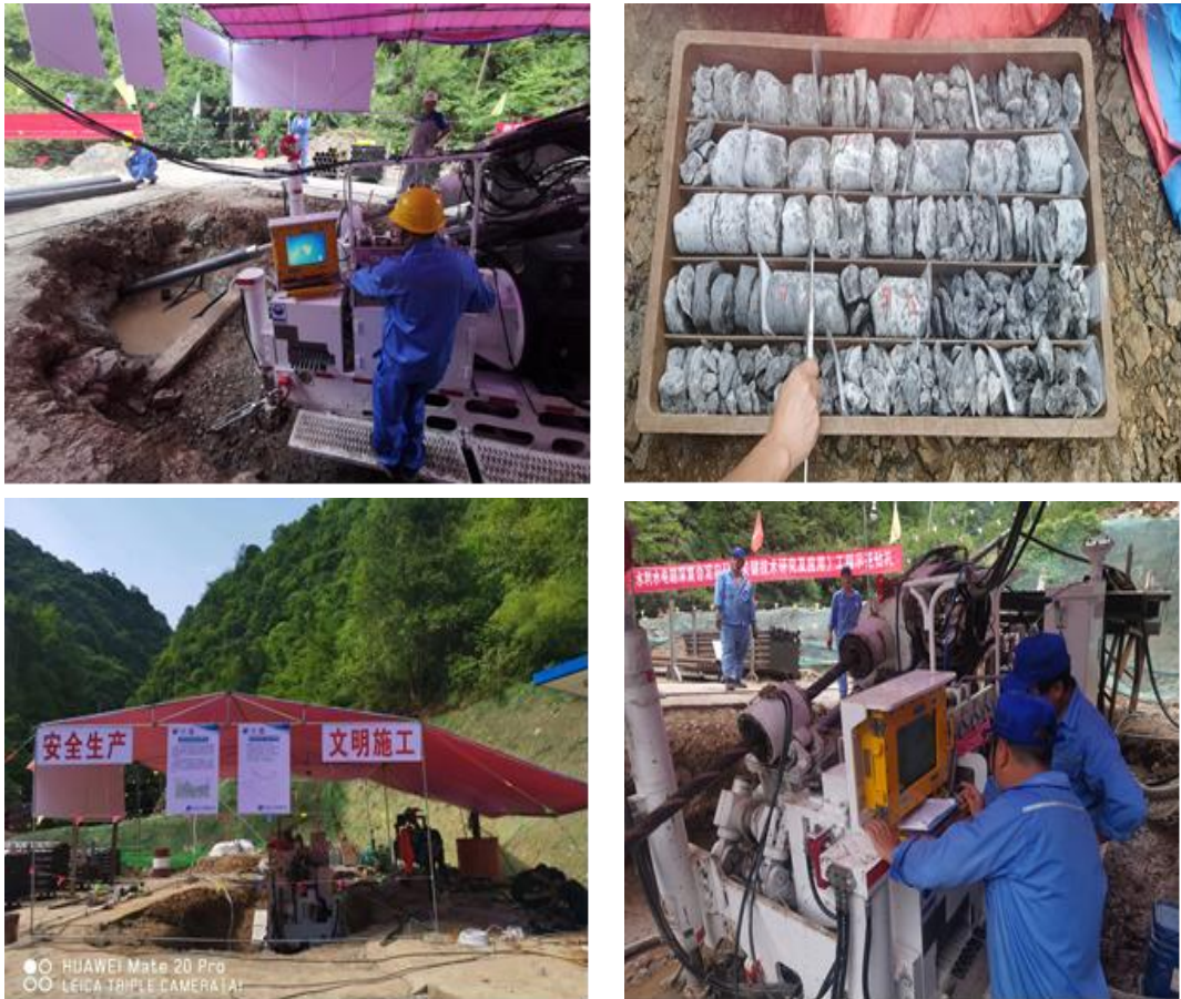
图 10-4 项目现场施工情况
