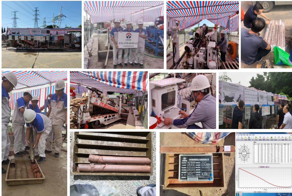
图 8 设备工艺现场应用情况
